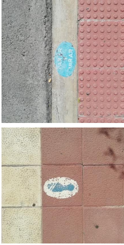
Ilustración 53. Ejemplo de señalización horizontal Camino escolar seguro.
