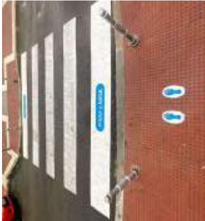
Ilustración 27. Señalización horizontal mediante pintura de los caminos escolares. Fuente: Crónica Norte.
