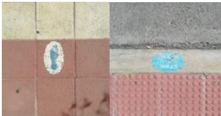
Ilustración 50. Ejemplo de señalización horizontal Camino escolar seguro
