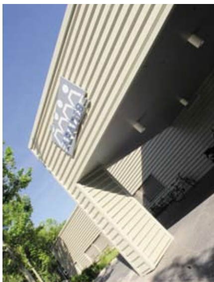
Vista del nuevo edificio que se inaugurará el próximo 30 de junio.
