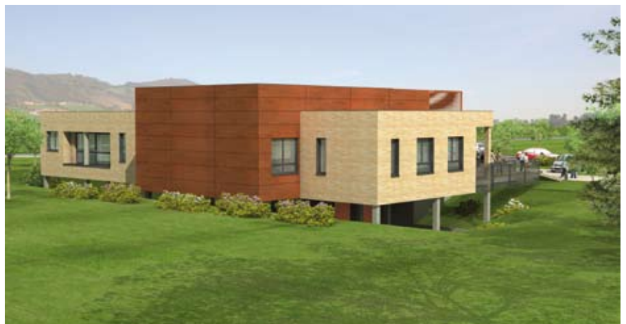
La instalación consta de una sola planta, tiene una zona de aparcamiento, una sala multiusos y un local para la Policía. El edificio centralizará los servicios municipales para la zona.
