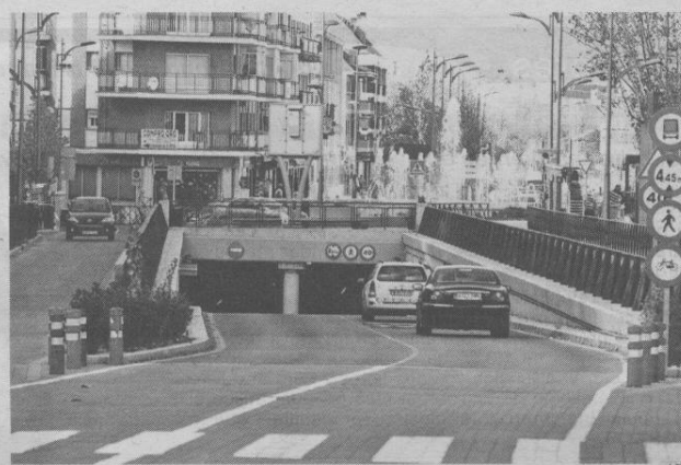
El túnel de la polémica costó 40 millones de euros
