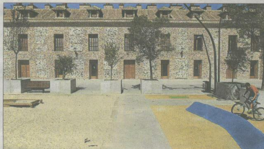
Viviendas de la plaza que han sido rehabilitadas por la empresa mixta. / A. H.
