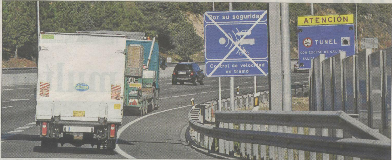
En la imagen tomada ayer se ve un cartel que informa, junto al túnel de Guadarrama, de la instalación del nuevo 'radar de tramo', que aún no funciona, dentro de la infraestructura. / SERGIO ENRIQUEZ
