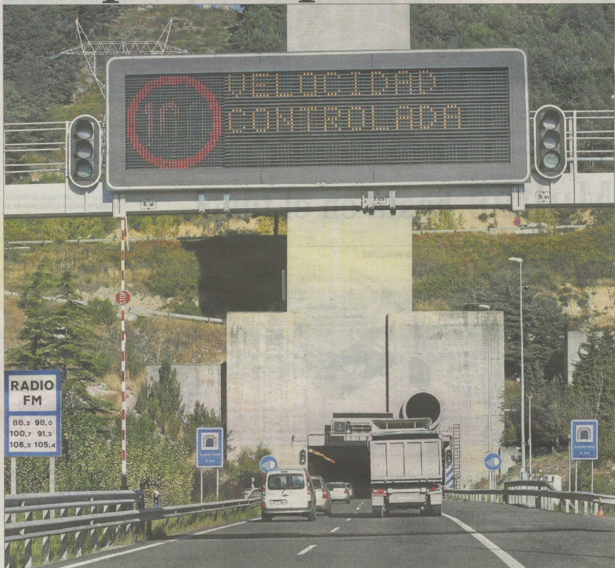
Panel informando del control de velocidad a la entrada del túnel de Guadarrama, en una imagen tomada ayer, / SERGIO ENRIQUEZ-NISTAL
