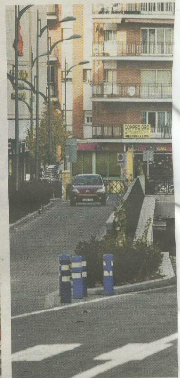
DESPUÉS La inauguración tuvo lugar en octubre de 2008. Los vecinos critican su coste y se quejan de que casi nadie utiliza el aparcamiento.
