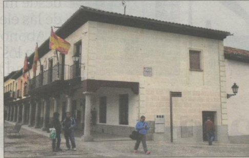
Entrada a la galería. La puerta de la derecha es la que da acceso a una vivienda y también a una galería que el Ayuntamiento ha dejado abandonada, según un vecino que ha presentado una denuncia.
