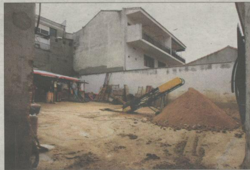
¿Obras terminadas? El Ayuntamiento señala que las obras de rehabilitación están terminadas, pero el lunes aún había tierra y ayer se podían ver varias cintas para transportar tierra.
