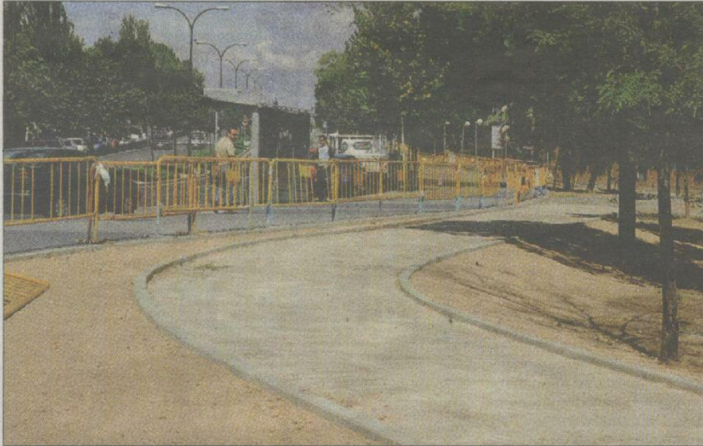
Una zona de Tejas Verdes en donde ya han comenzado las obras de remodelación
