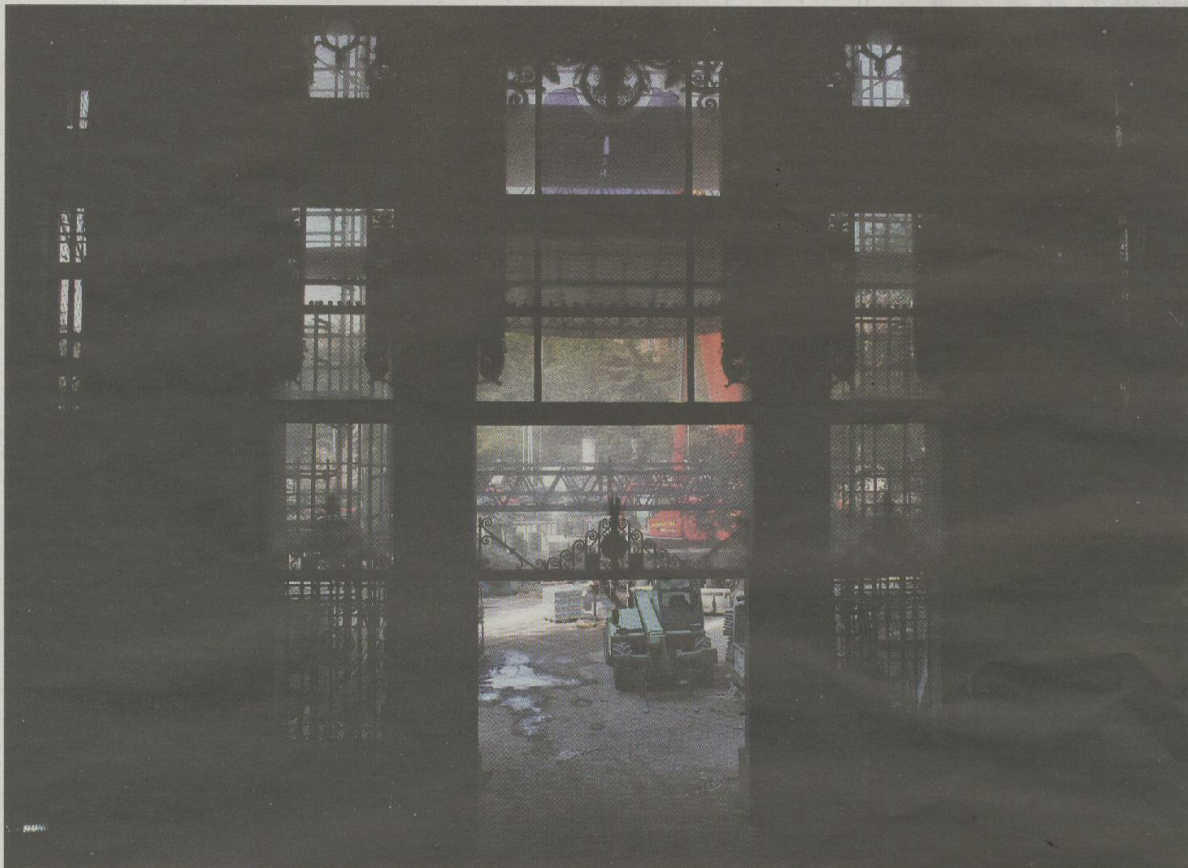
Obras en el palacio de Cibeles, sede del Ayuntamiento. / ÁLVARO GARCÍA
