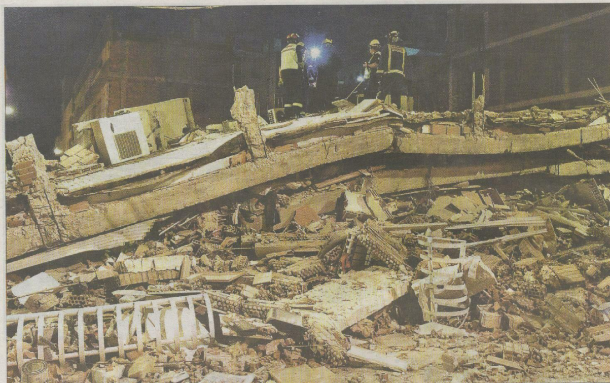
Equipos de rescate buscan entre los escombros de un edificio destruido por el terremoto en Lorca. / FRANCISCO BONILLA
