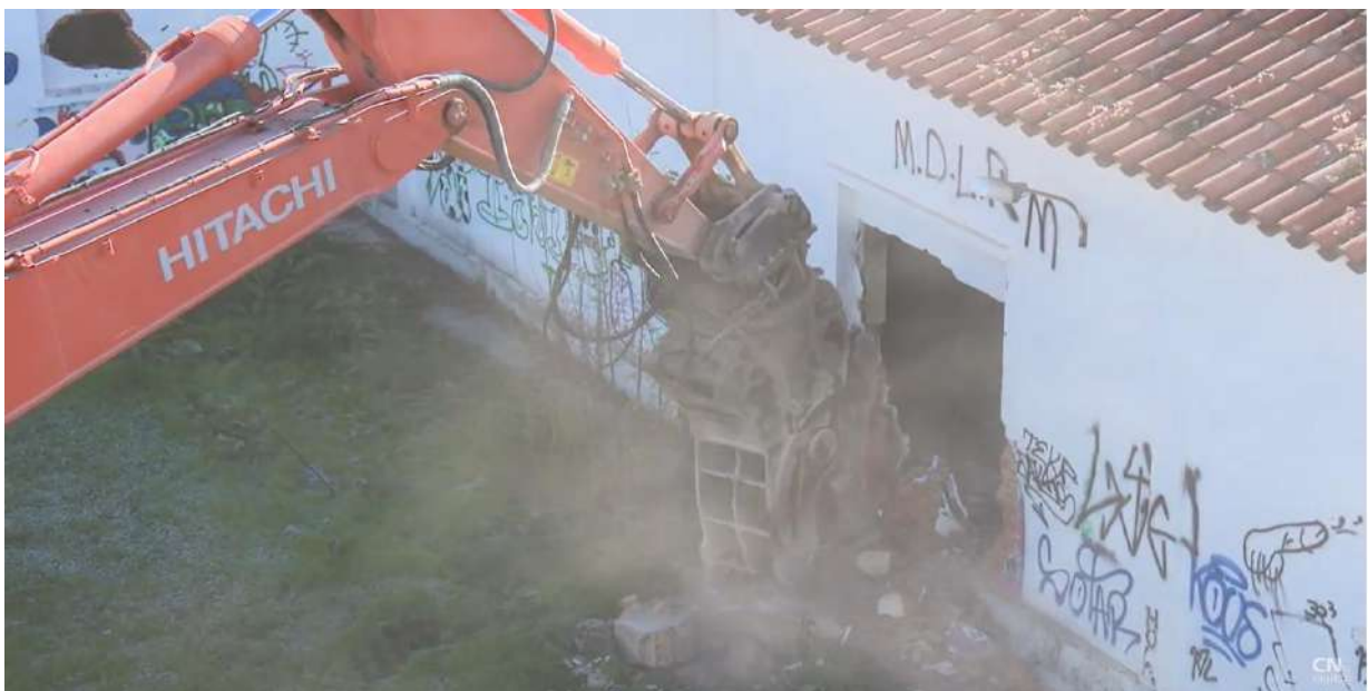
Fig. 20 Demolición del edificio H
