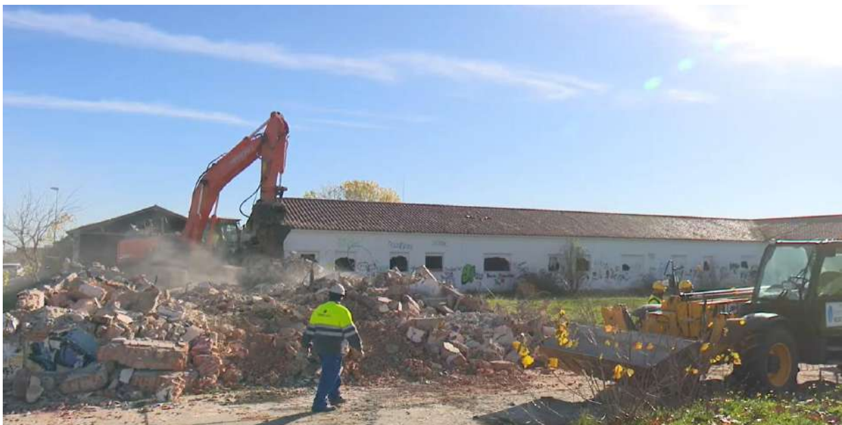
Fig. 22. Demoliciones de las edificaciones militares
