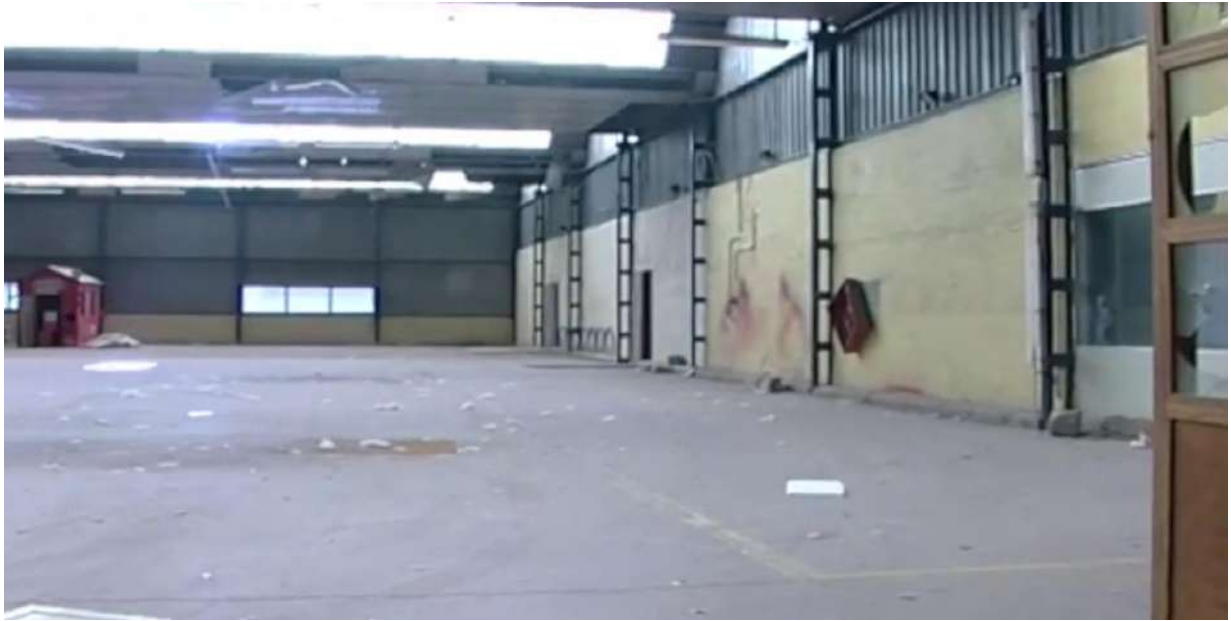
Fig. 17. Interior de hangar
