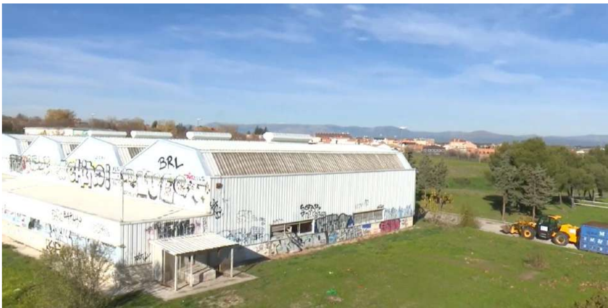
Fig. 16 . Hangar en estado de abandono
