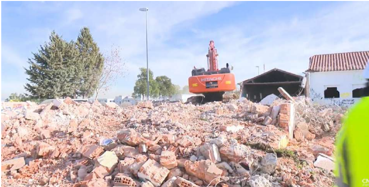
Fig. 19 . Proceso de demolición de los edificios militares
