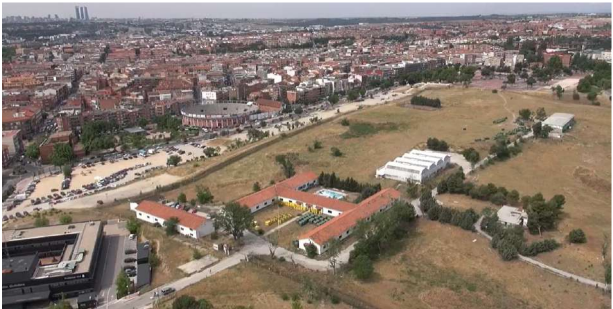
Fig. 10 Vista aérea. Edificio H y hangar. A la izquierda de la foto, edificio de protección civil
