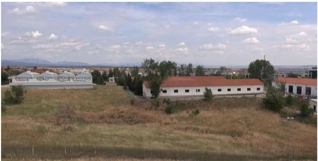
Fig. 14. Edificio H y Hangar
