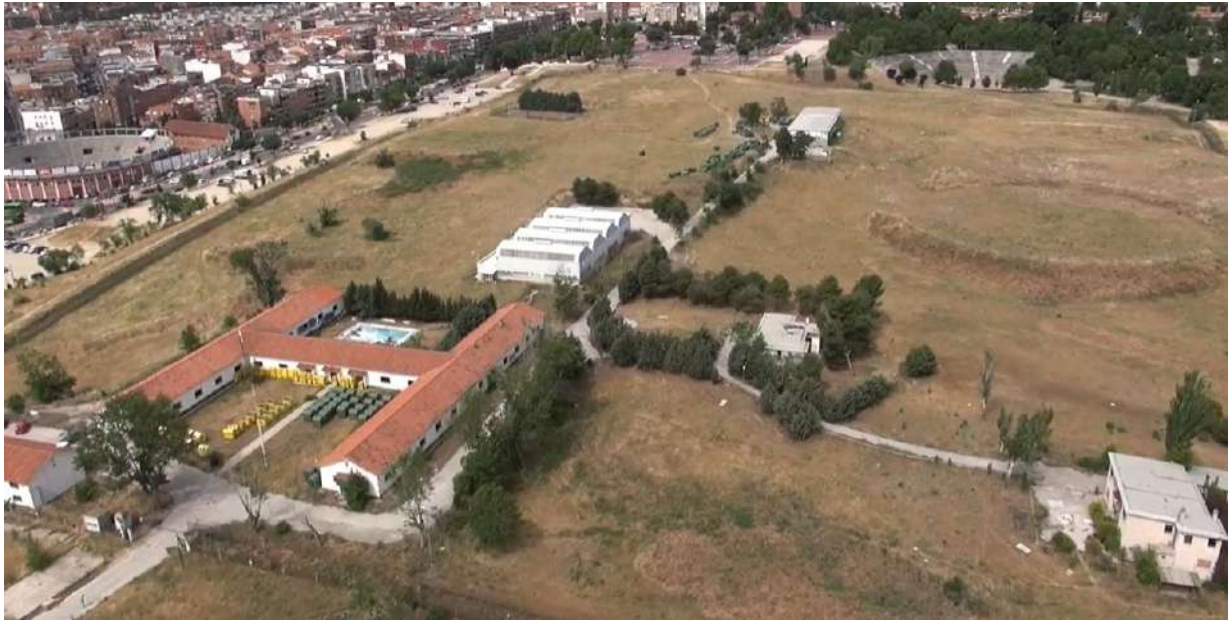
Fig. 13 Vista aérea. Edificio H, piscina, hangar, zona de antenas.
