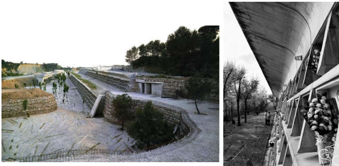
Edificaciones de los enterramientos en nicho, en Igualada.
