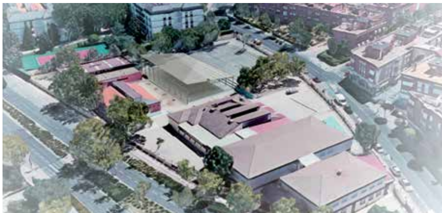
▲ Vista aérea de la cubierta del CEIP Príncipe Felipe.
