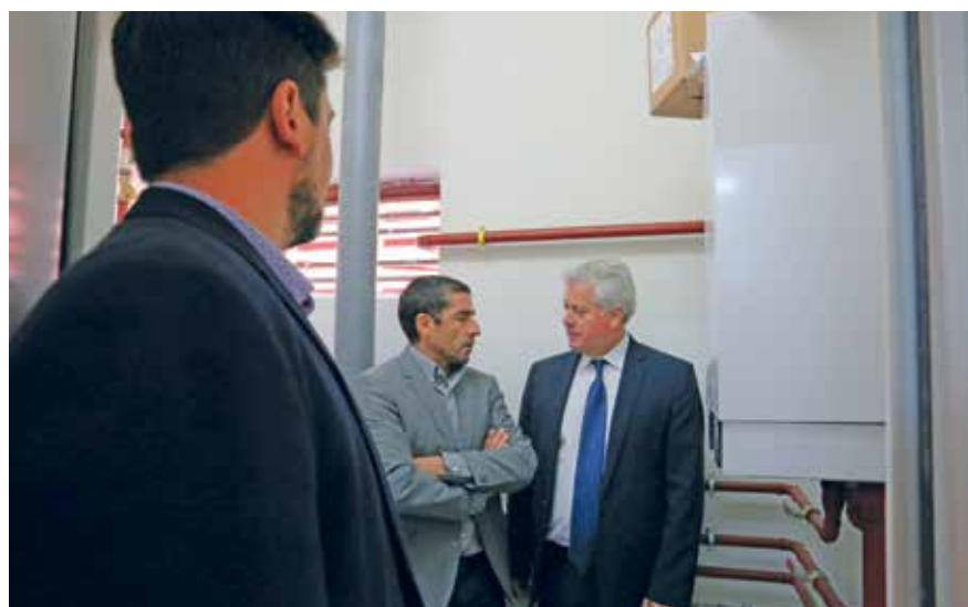
▲ Las sustitución de las calderas en los CEIP Buero Vallejo y Valvanera ha costado 140.000 euros.
