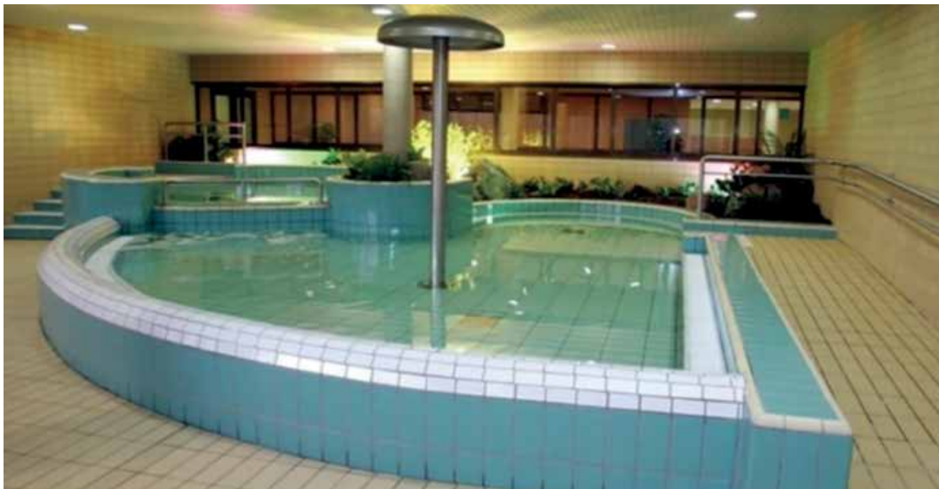
▲ Vista de una de las piscinas reacondicionadas.
