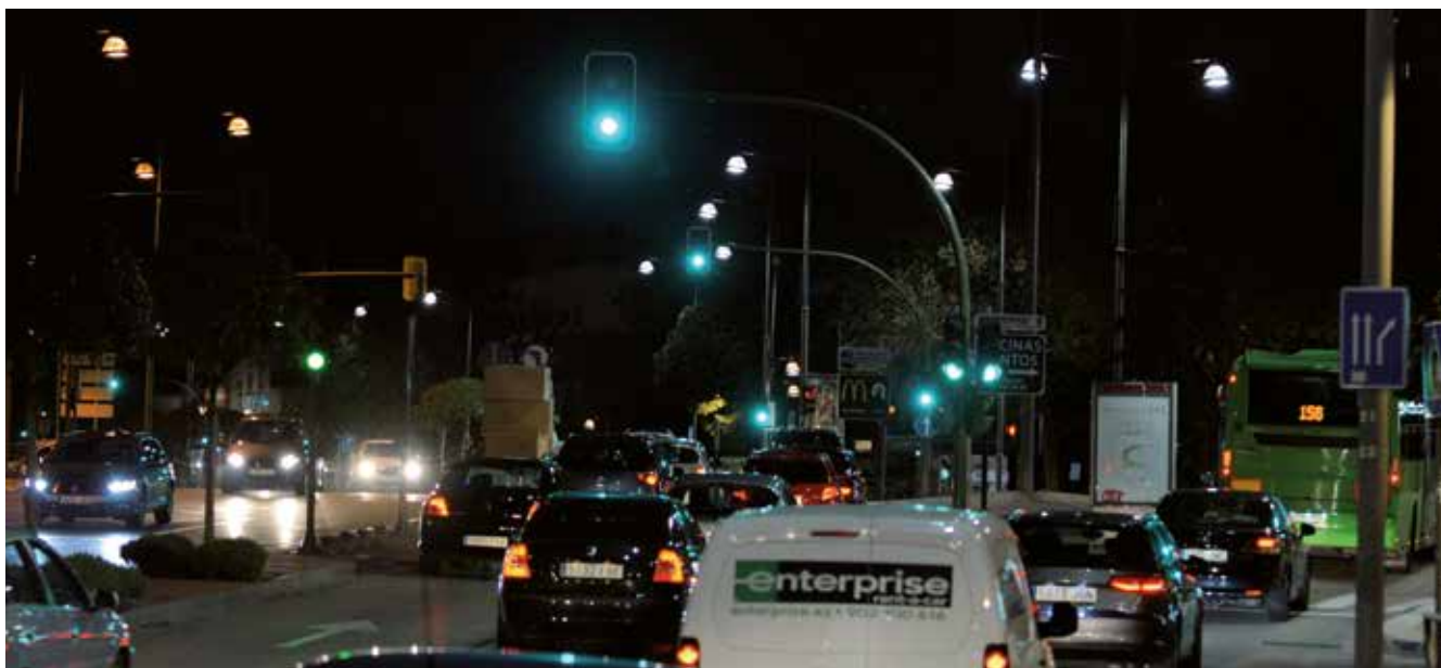
▲ Nuevas farolas de la Avenida de España, instaladas en pleno casco urbano.
