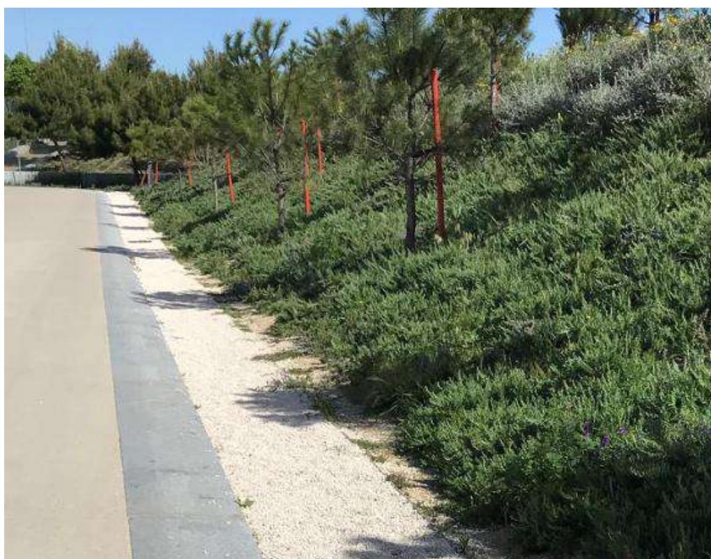
Dren filtrante en Madrid Río – Puente de la Princesa, en Madrid. Fuente: Ayto. de Madrid.
